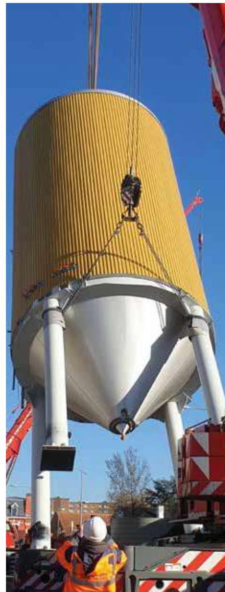
Ziemex assure le montage des équipements sur site.
